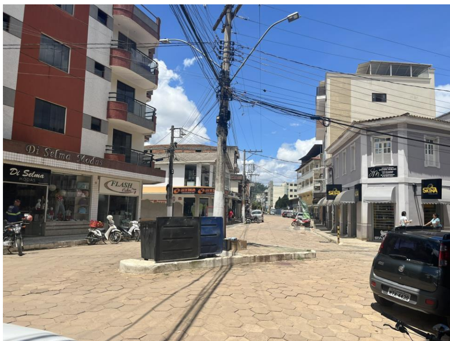
Imagem 01 - Vista da Rua Afonso Cláudio.
