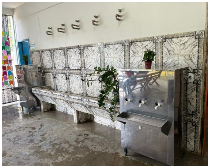
Imagem 05: Vista área tanque e bebedouros
