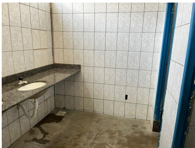
Imagem 06: Vista interna banheiro masculino alunos
